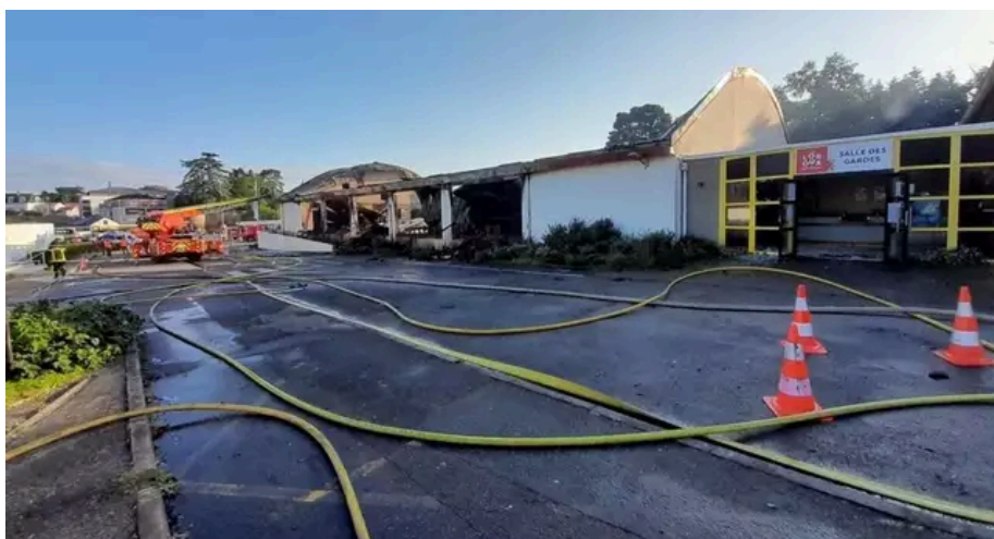
Triste décor ce vendredi matin 24 mai. Le palais des congrès du Loroux-Bottreau a été complètement détruit par les flammes. L'action des pompiers a permis d'éviter la propagation à une salle de sport contiguë. Ouest-France
