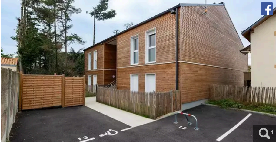
À La Montagne, des maisons avec ossatures en bois fabriquées par Macoretz, majoritairement hors site. © Macoretz Scop
