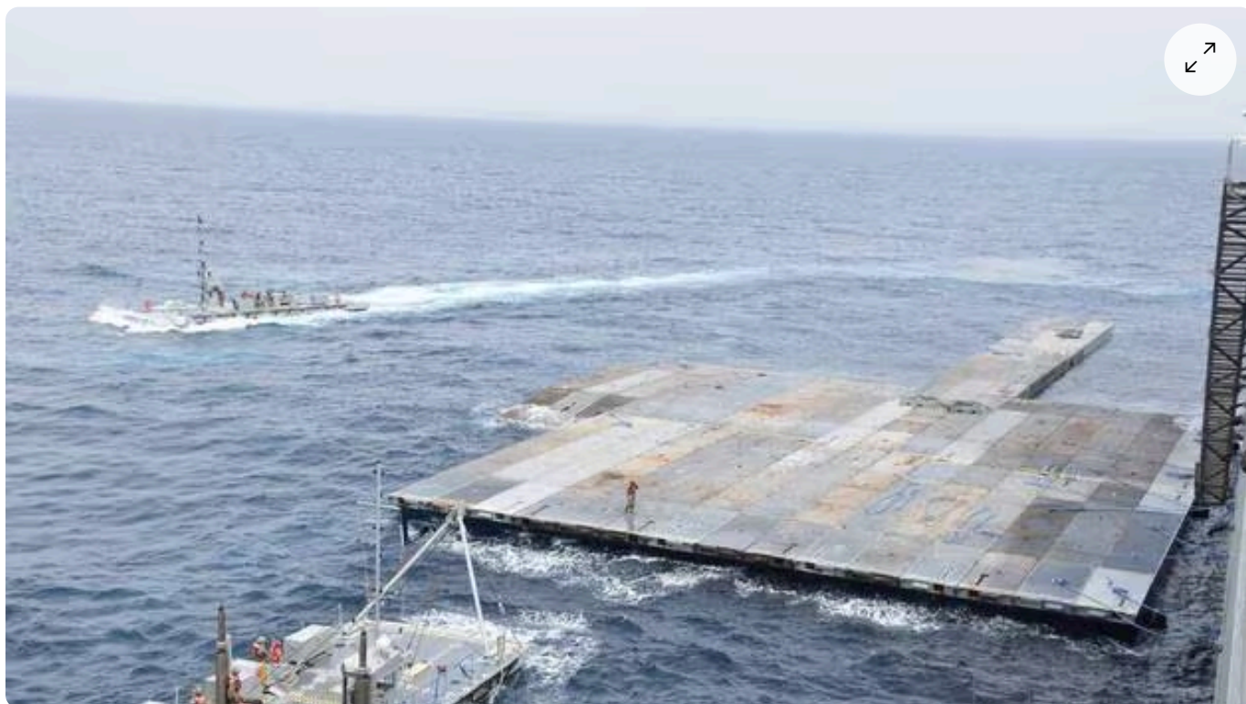
Des soldats de la 7th Transportation Brigade et des marins du MV Roy P. Benavidez assemblent les éléments du quai flottant qui permettra de décharger les cargos et les porte-conteneurs qui ne peuvent s'approcher du rivage. | U.S. ARMY CENTRAL
