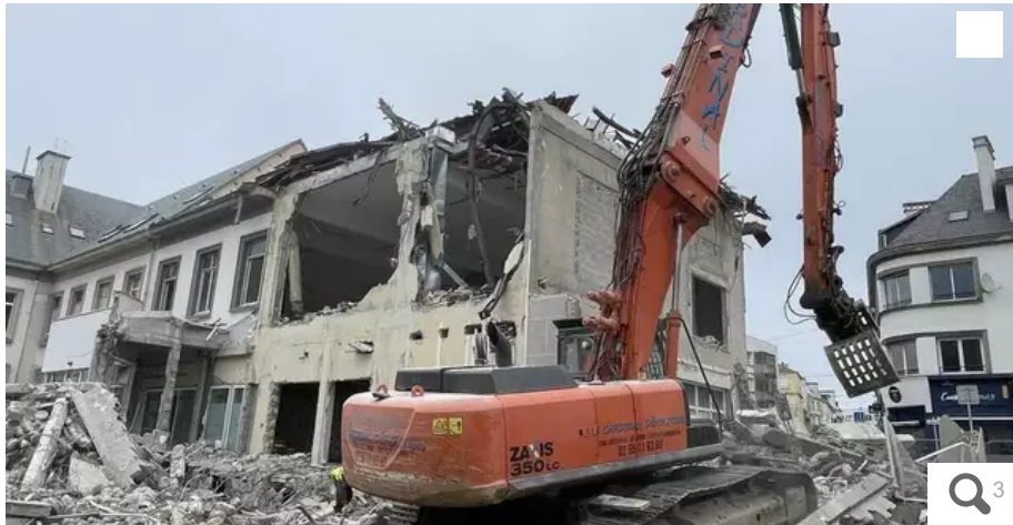
La démolition du bâtiment côté rue Nayel devrait être achevée en milieu de semaine prochaine. Débutera alors la phase principale, située côté Quai des Indes. © Ouest-France
