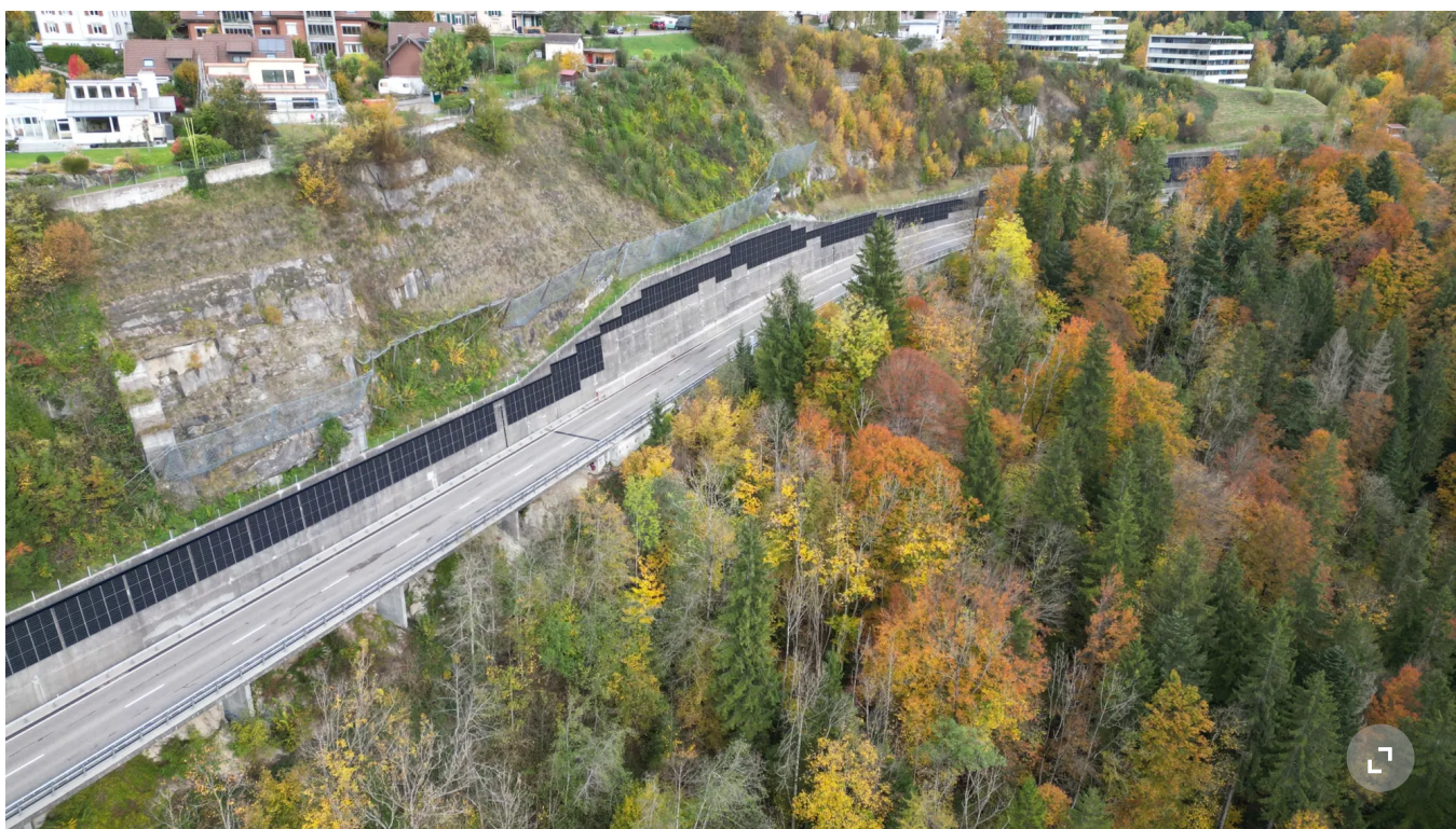
Nouvelle installation solaire sur le contournement de Teufen, en Appenzell Rhodes-Extérieures.
