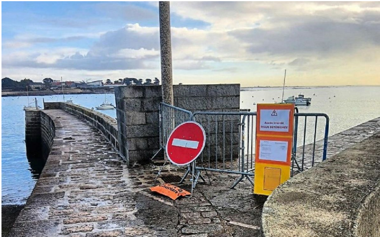
Fermeture de la digue Sud-Est d'accès du môle de Lomener (Ville de Ploemeur)
