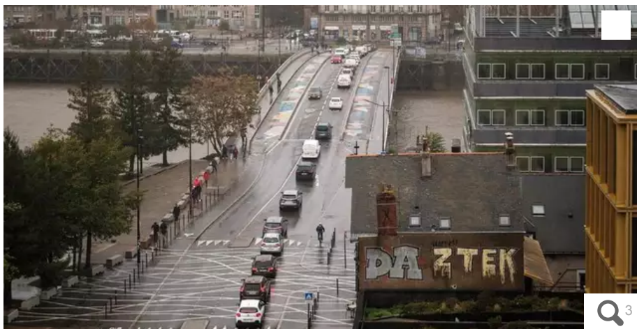
Le pont Anne-de-Bretagne fermera totalement à la circulation automobile pendant un an, à compter du printemps 2024. © Photo Presse Océan-Simon Torlotin
