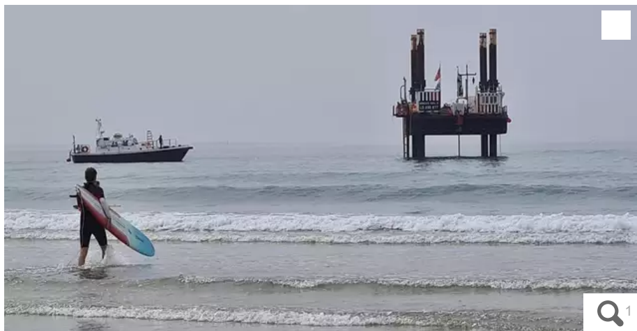
Ce mois de septembre 2023, une plate-forme temporaire a été mise en place par RTE à Kerhillio à Erdeven pour réaliser des sondages permettant de caractériser le sol, dans le cadre du projet de raccordement électrique du parc éolien en mer prévu en Bretagne-Sud. © Ouest-France
