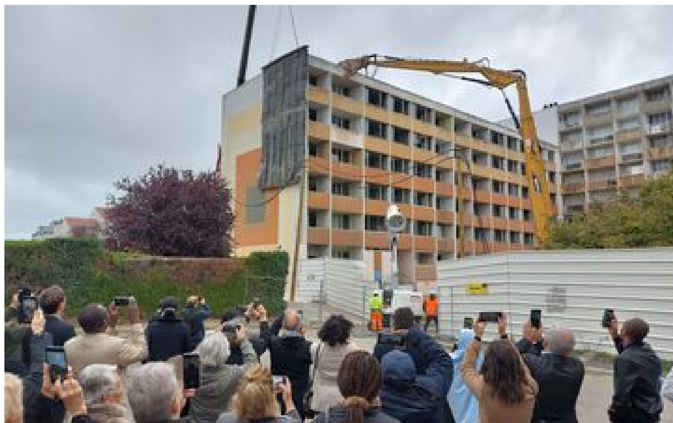
Travaux dans les cités sensibles : à Montereau, le gérant d'une société de démolition racketté P
