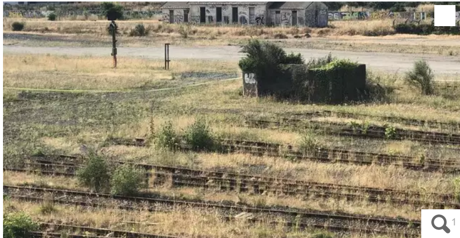
La base vie de l'écocentre intégrera d'anciens locaux de la SNCF et abritera un espace pédagogique. © Photo Presse Océan-RC
