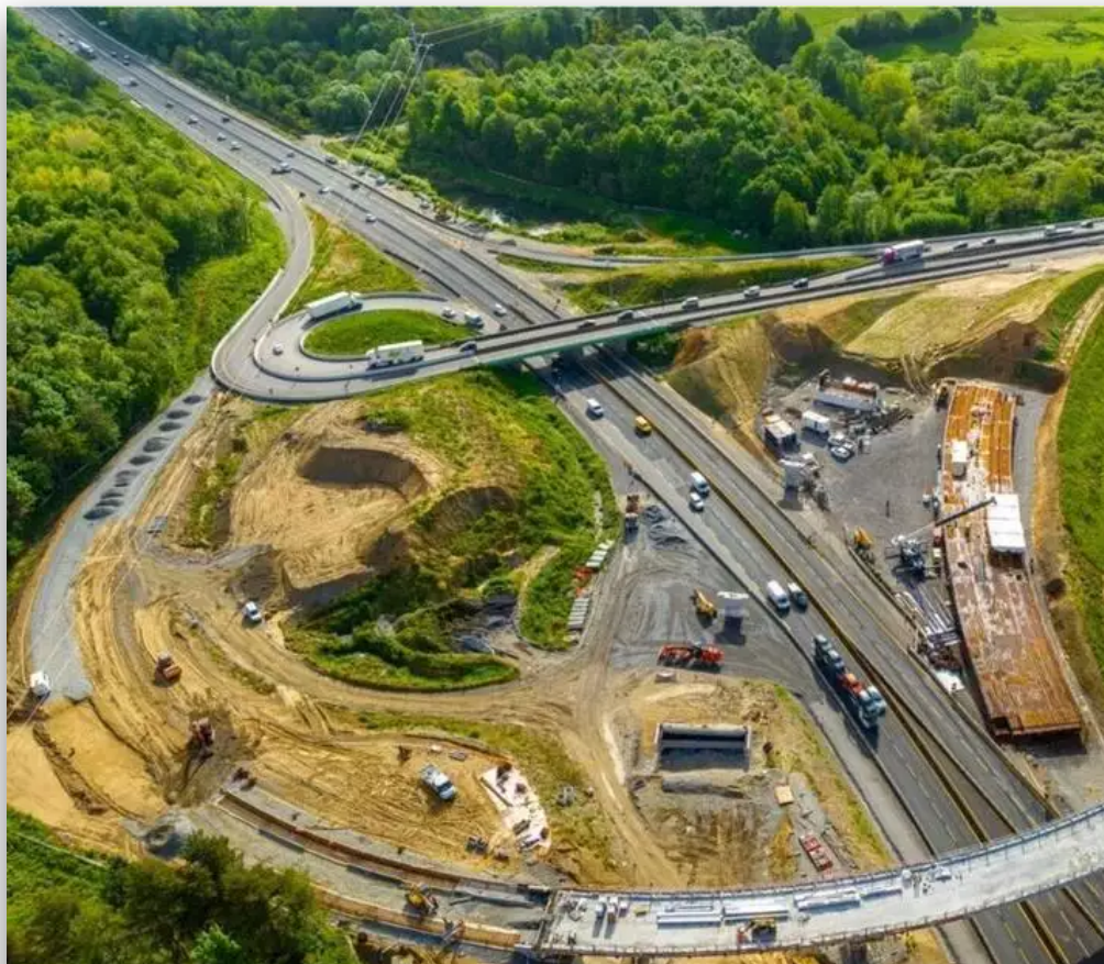
Assemblée sur place, la charpente métallique du viaduc est sera posée dans la nuit du 12 au 13 juin avant d'être bétonnée. © Photo Gael A
