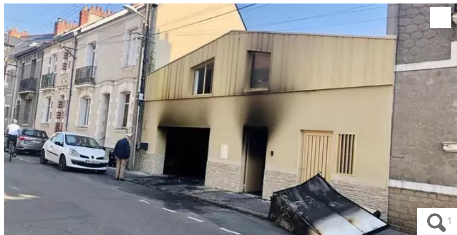
Selon les pompiers, les dégâts liés à la propagation de la fumée sont importants. © Ouest-France
