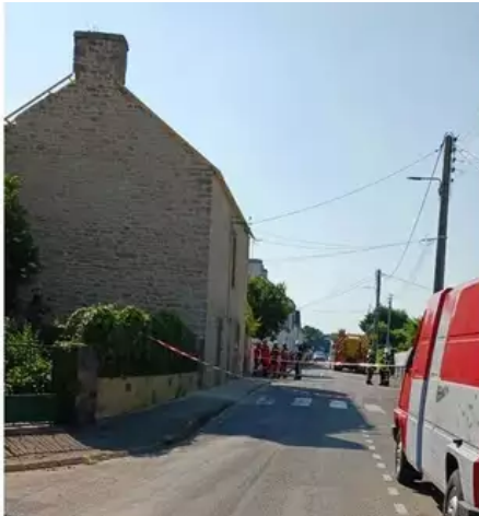
Une maison en travaux, située rue Eugène-Le Coupavec, à Plœmeur, a été en partie victime d'un effondrement. D'importants moyens de secours de tout le département ont été engagés. © Ouest-France
