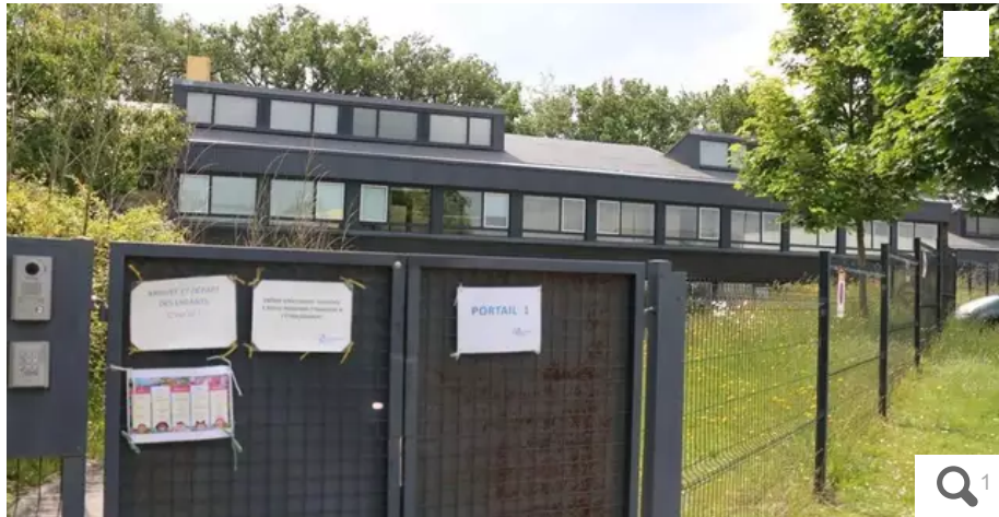
Fermeture du périscolaire par arrêté préfectoral, arrêts maladie en série, loyers impayés... L'International school of Nantes, école privée hors contrat pour enfants et ados, est en pleine turbulence. Le site de Saint-Herblain va fermer. © Ouest-France
