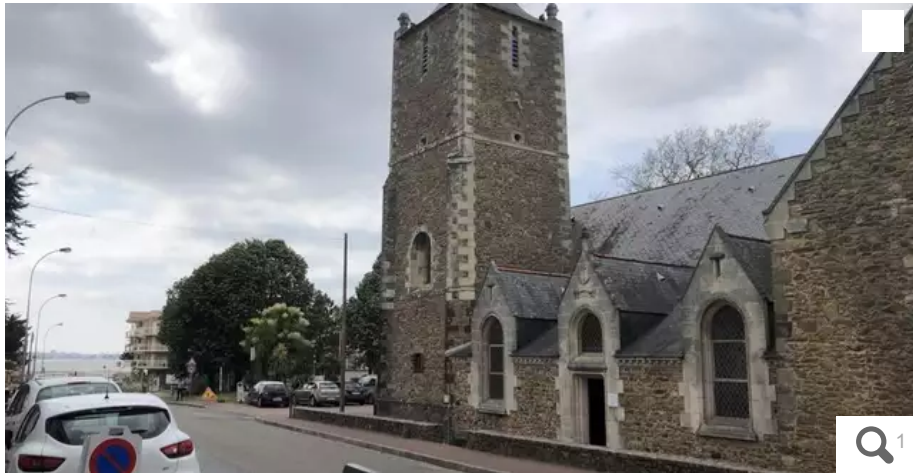
Dans la rue de l'Église et d'autres rues, le stationnement sera interdit ce mercredi après-midi. © Photo Presse Océan-JCJ
