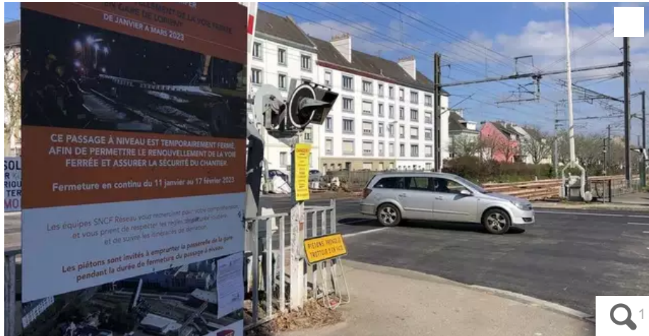
Le passage à niveau était fermé depuis le début de l'année 2023 pour permettre des travaux de renouvellement de la voie ferrée et d'aiguillages. © Ouest-France
