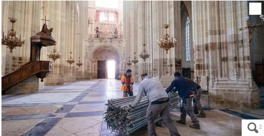
Des ouvriers ont démonté les échafaudages pour faire place nette avant les travaux restauration. © Photo PO-Simon Torlotin
