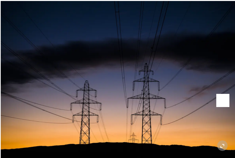
Lignes à haute tension au-dessus de Romanel (VD). Des
