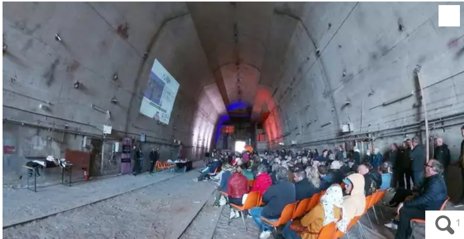
Avec ses 13,7 mètres de hauteur, 16 mètres de large et 82 m de profondeur, le dom-bunker Ouest de l'aire de réparation navale a les dimensions d'une cathédrale. © Ouest-France
