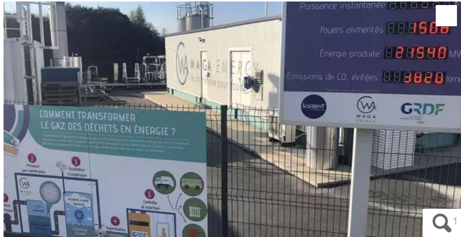
Installée fin 2019 sur le site du centre d'enfouissement de Kermat, à Inzinzac-Lochrist (Morbihan), la Wagabox produit du biométhane à partir de déchets. © Ouest-France
