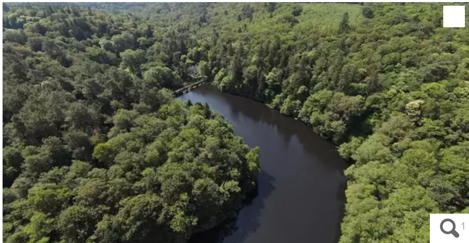
Le barrage inutilisé de Ty Mat va être démoli à Inzinzac-Lochrist (Morbihan). Le but ? Restaurer une continuité écologique et sédimentaire. © Lorient Agglo
