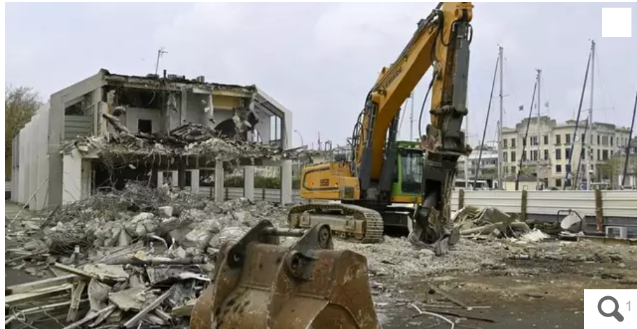
Démolition de la Maison de la Mer quai de Rohan, qui abritait, entre autres, le restaurant L'Aquarium. © Thierry Creux / Ouest-France
