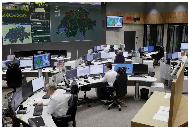
Le centre de conduite de Swissgrid à Aarau. | Swissgrid
