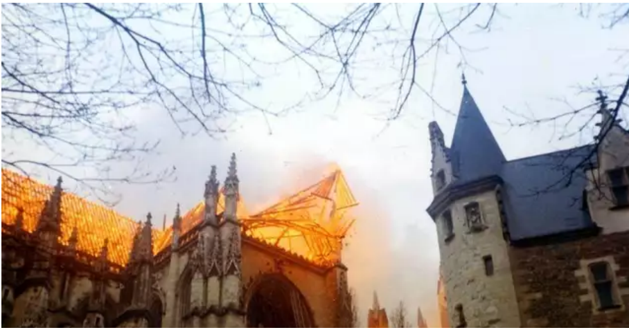
L'incendie a fait de gros dégâts. © Photo Presse Océan – Nathalie Bourreau
