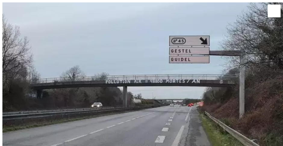
Le pont enjambant la voie express RN165, au niveau de Gestel (Morbihan), a été tagué la semaine dernière. © ARCHIVES OUEST-FRANCE
