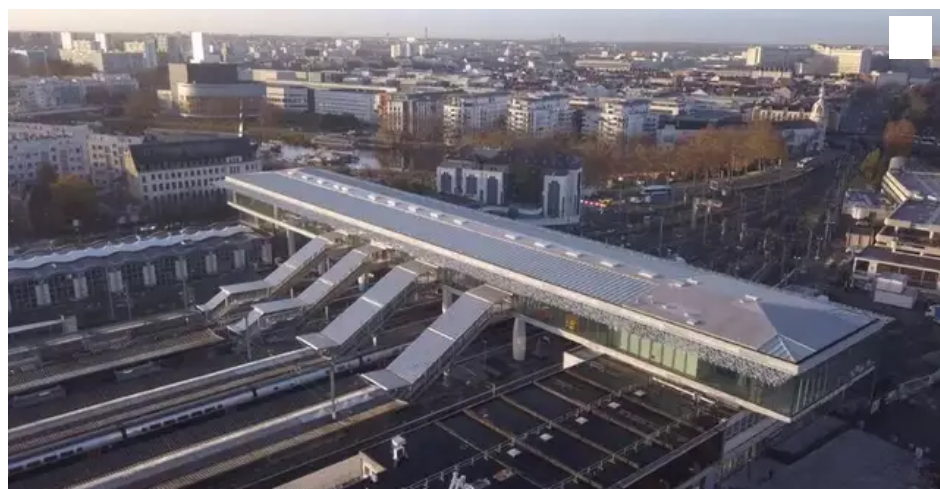
Survol par drone de la nouvelle gare mezzanine de Nantes © Simon Bénétou / Magenta Films
